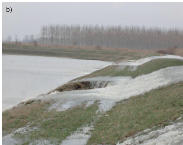
Fig. 18.20 - Tracimazione del fiume Loncon (14.11.2008), (Foto: a) Volontari di Protezione Civile del Distretto del portogruarese; b) Giuseppe Canali) .
