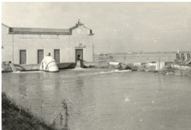
Fig. 18.6 - Idrovora scaricante sul Taglio del Sile, con visione del territorio allagato circostante (Musile di Piave - Novembre 1966 - Archivio Cav. Angelino Battistella).
