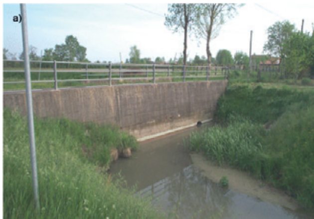
Fig. 18.15 - Criticità idrauliche: due esempi di riduzione della sezione di un canale.
