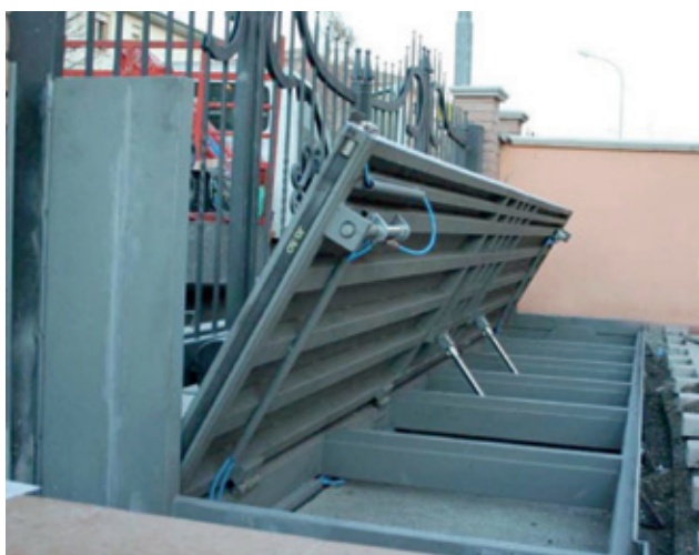
Fig. 18.18 - Barriera ribaltante antiallagamento.
