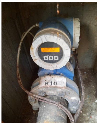
Figura 19 – Foto del misuratore di portata installato allo scarico
