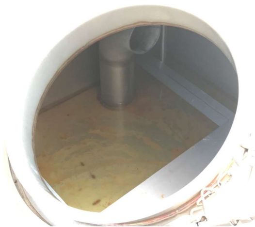
FOTO N. 4a e 4b: unità di miscelazione deo-air system collocata nel vicino impianto di Biogas e particolare dell'emulsione di oli essenziali contenuta all'interno
