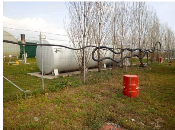
FOTO N. 3 tubazione deodorizzante lungo la recinzione sud impianto biogas
