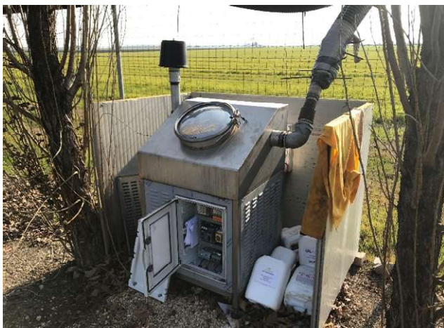
FOTO N. 4a e 4b: unità di miscelazione deo-air system collocata nel vicino impianto di Biogas e particolare dell'emulsione di oli essenziali contenuta all'interno
