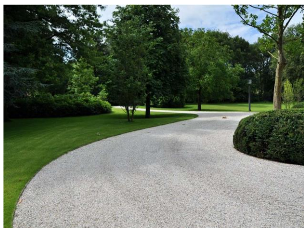
Fig. 5.1.1 – Esempio di percorso in calcestre e dettaglio della lamina in ferro di delimitazione
