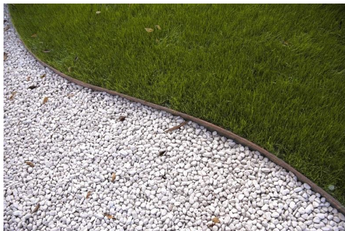
Fig. 5.1.1 – Esempio di percorso in calcestre e dettaglio della lamina in ferro di delimitazione
